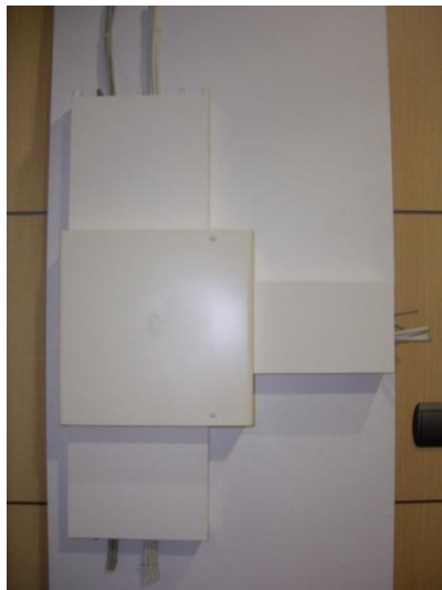
Figura 45 – Coluna e transição com calhas, calha e cantoneira para ângulo exterior
