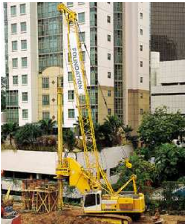
45 – Equipamento execução estacas
