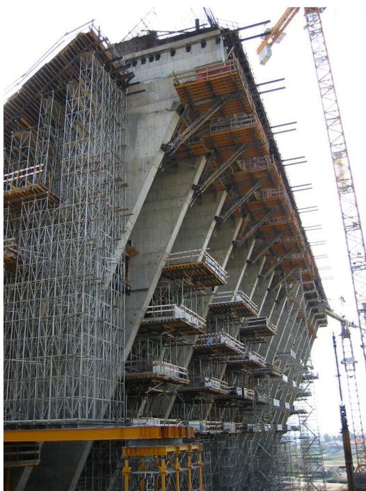
Figura 20 - Plataformas adequadas de trabalho
