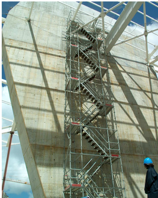
Figura 29 - Escada de acesso adequada
