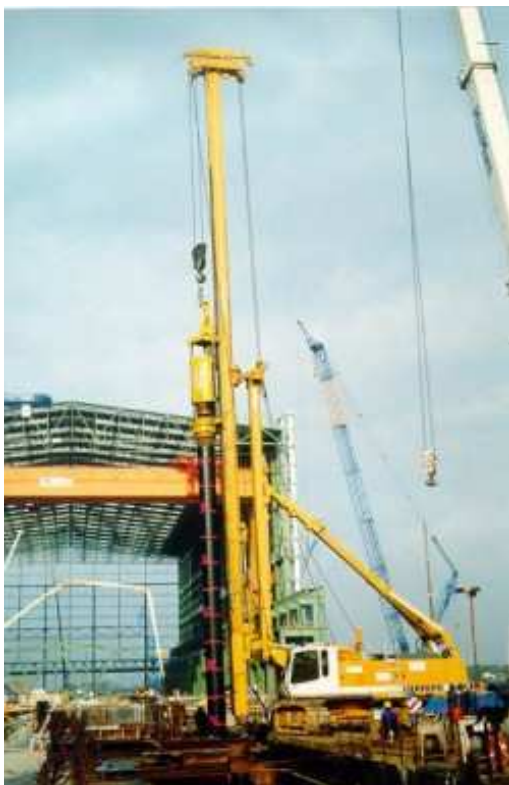
47 – Equipamento execução estacas
