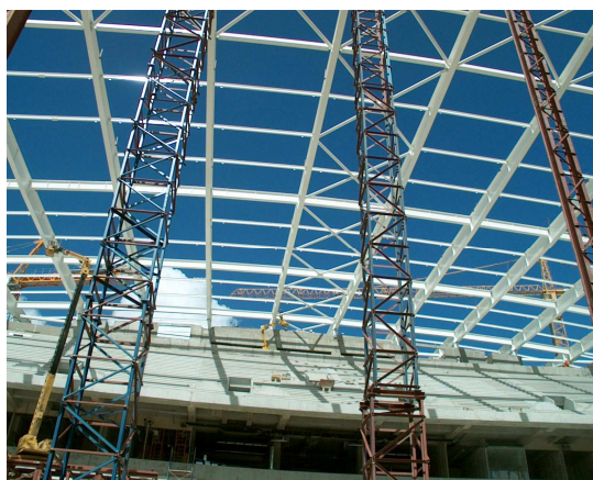
Figura 27 - Acesso a locais elevados em boas condições
