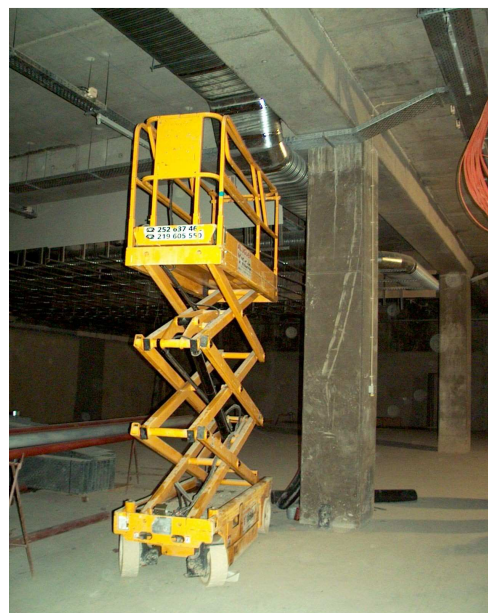
Figura 25 - Plataforma elevatória para boas condições de trabalho em altura
