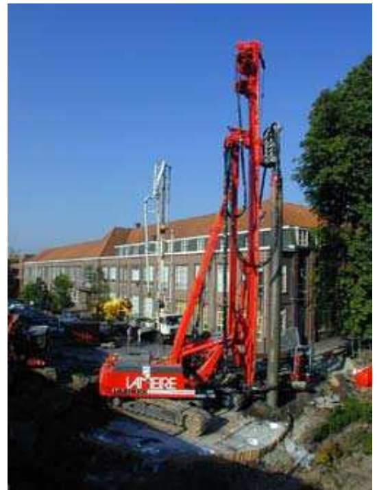
46 – Equipamento execução estacas
