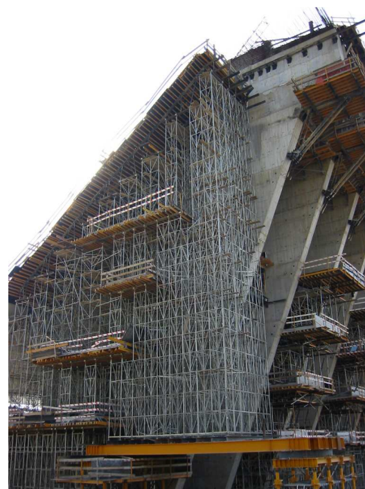
Figura 21 - Escoramento com projecto específico
