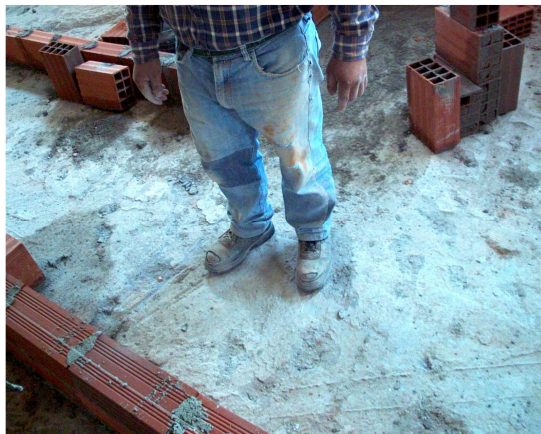
Figura 16 - Botas sem condições de segurança
