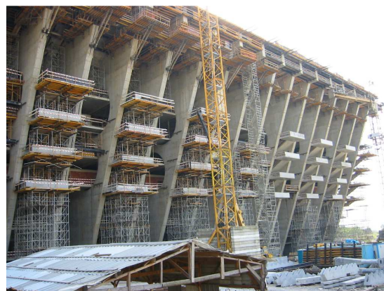
Figura 23 - Escadas de acesso com boas condições
