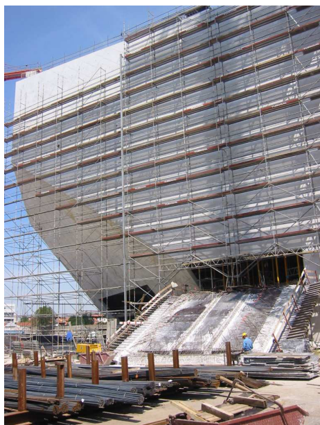
Figura 24 - Andaime bem executado
