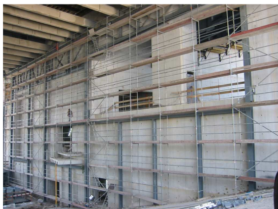
Figura 22 - Andaime bem executado
