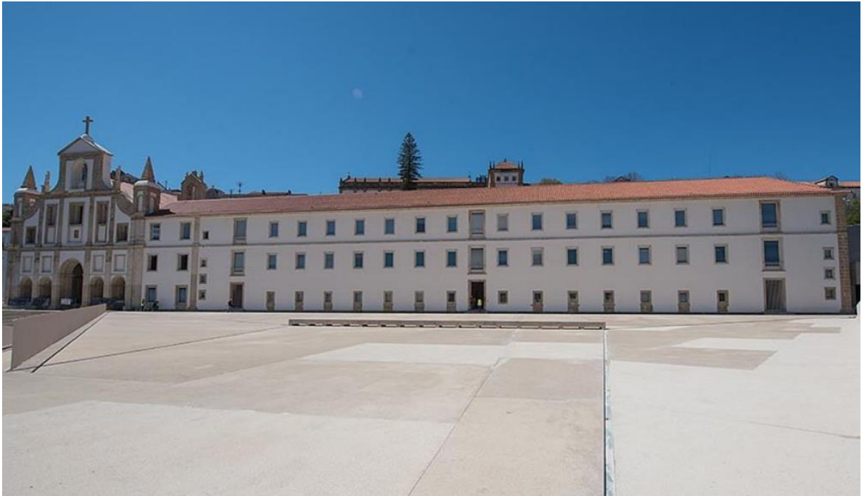
Fig. 4.5 - Convento de São Francisco (Coimbra), após a intervenção, 2018 [35]
