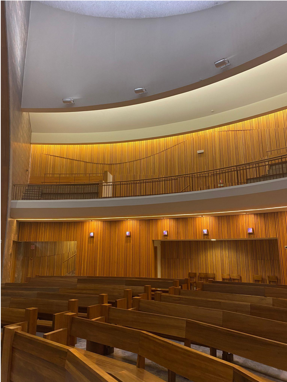
Fig. 4.15 – Ressonadores agrupados (ripas de madeira com absorvente colocadas nas paredes da igreja de Nossa Senhora dos Navegantes [foto do autor].
