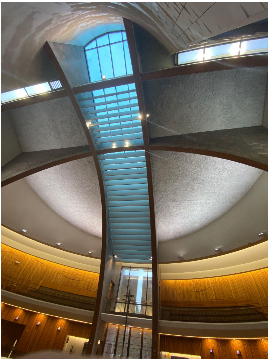
Fig. 4.14 – K-13 projetado no teto da igreja de Nossa Senhora dos Navegantes [foto do autor].
