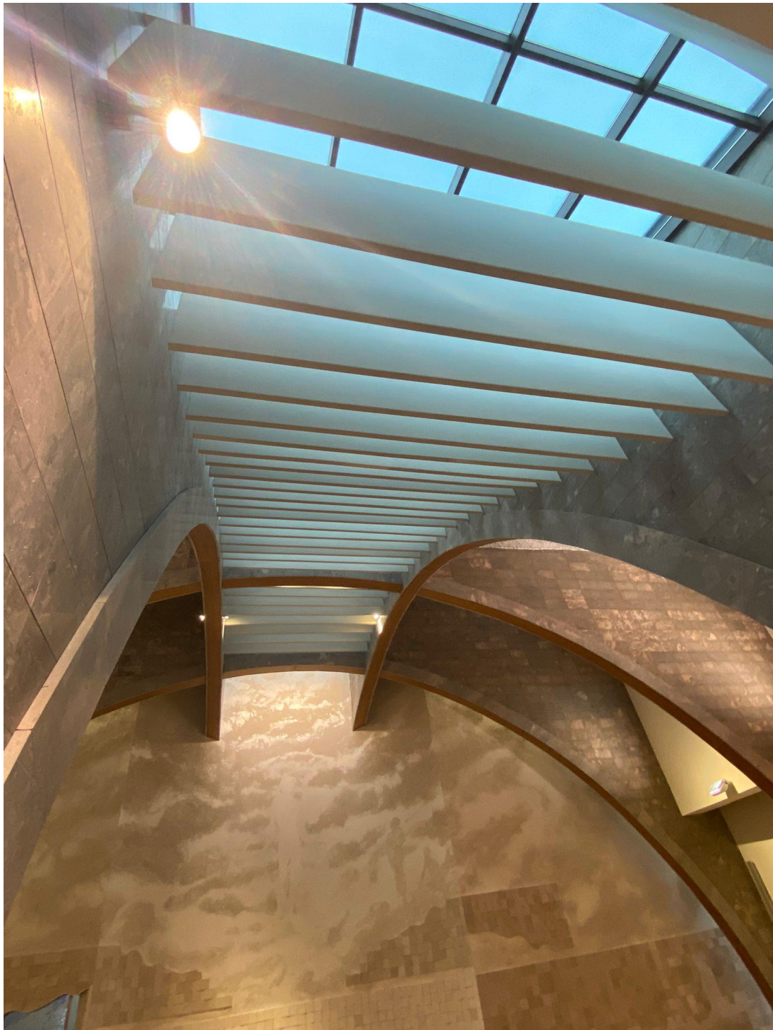
Fig. 4.13 – Placas acústicas suspensas ( baffles ) no teto da nave da igreja de Nossa Senhora dos Navegantes [foto do autor].
