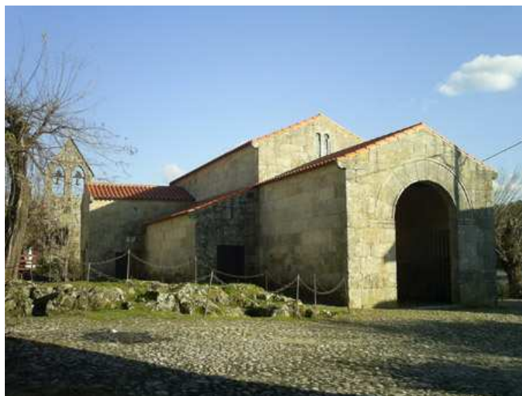
Fig. 40.1 – Vista geral da igreja de São Pedro de Lourosa [71]
