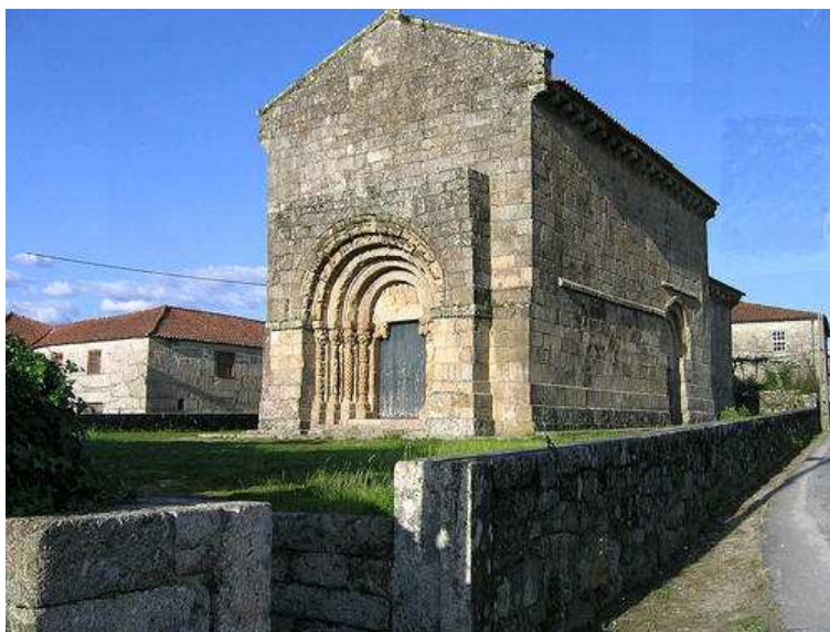
Fig. 3.1 – Fachada principal da igreja de Bravães [11]
