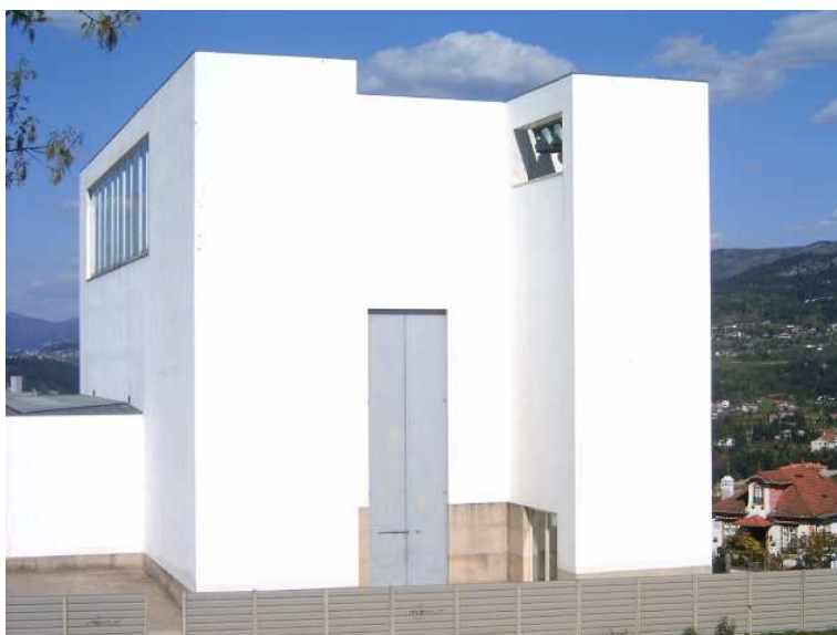
Fig. 22.1 – Fachada principal da igreja de Santa Maria (Marco de Canaveses) [44]
