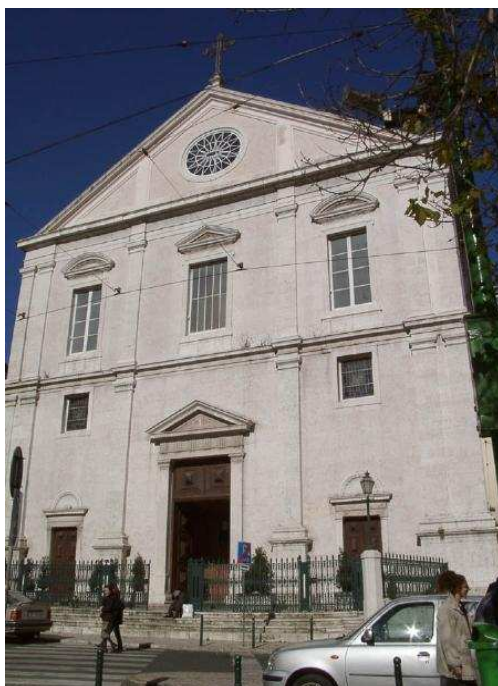
Fig. 43.1 – Fachada principal da igreja de São Roque (Lisboa) [75]
