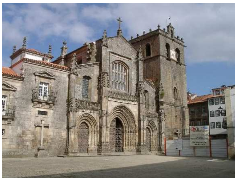
Fig. 45.1 – Fachada principal da Sé de Lamego [78]
