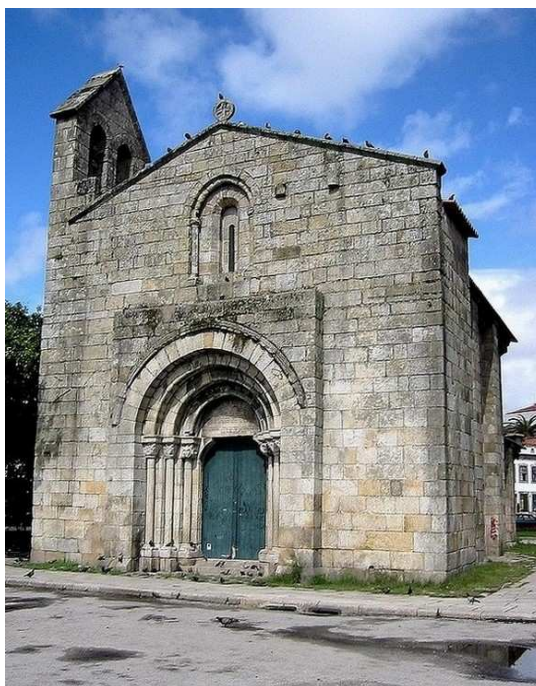
Fig. 36.1 – Fachada principal da igreja de São Martinho de Cedofeita (Porto) [64]
