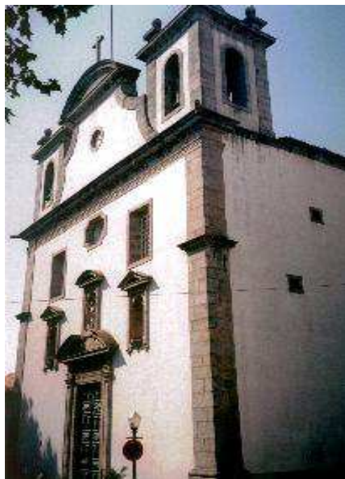
Fig. 32.2 – Fachada principal da igreja de São João Baptista (Porto) [3]
