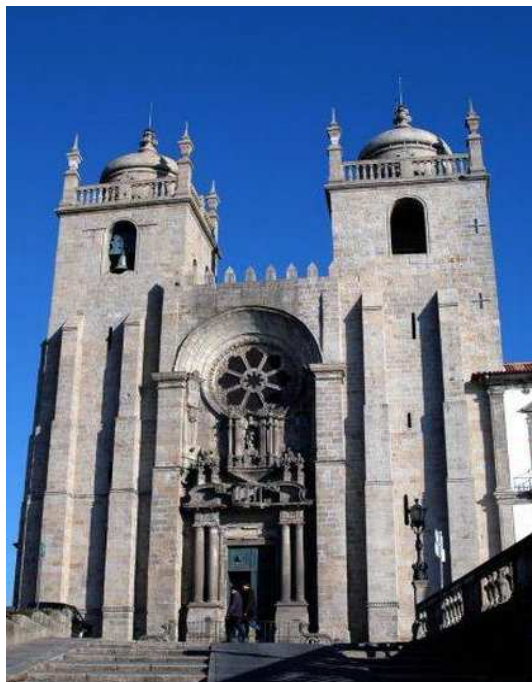
Fig. 46.2 – Fachada principal da Sé do Porto [80]
