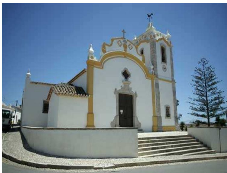
Fig. 52.1 – Fachada principal da igreja Matriz de Vila do Bispo [91]
