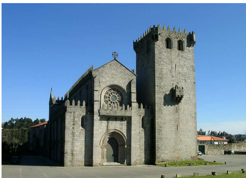
Fig. 12.1 – Fachada principal da igreja do mosteiro de Leça do Bailio [25]
