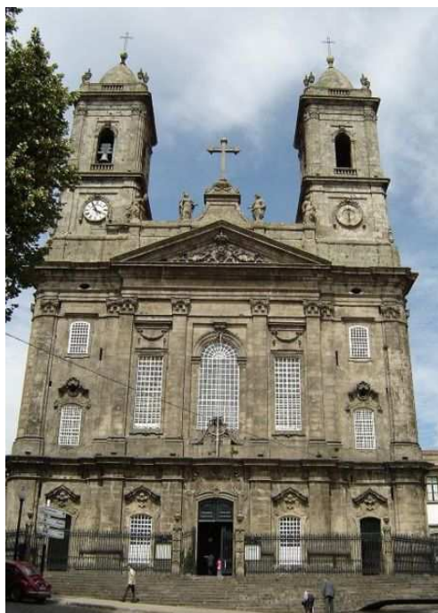
Fig. 11.1 – Fachada principal da igreja da Lapa (Porto) [23]
