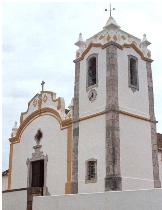
Fig. 52.2 – Torre sineira da igreja Matriz de Vila do Bispo [91]
