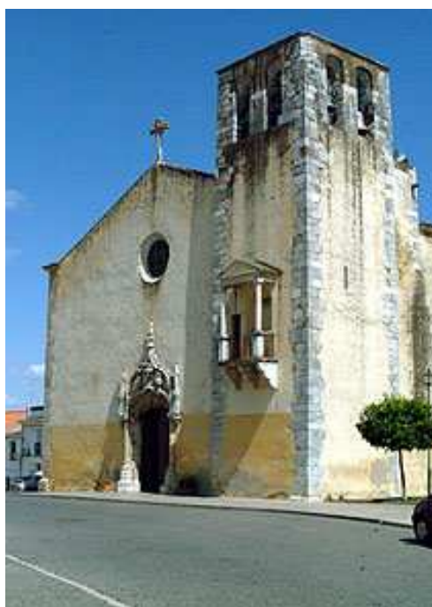
Fig. 31.1 – Fachada principal da igreja de São João Baptista (Moura) [58]
