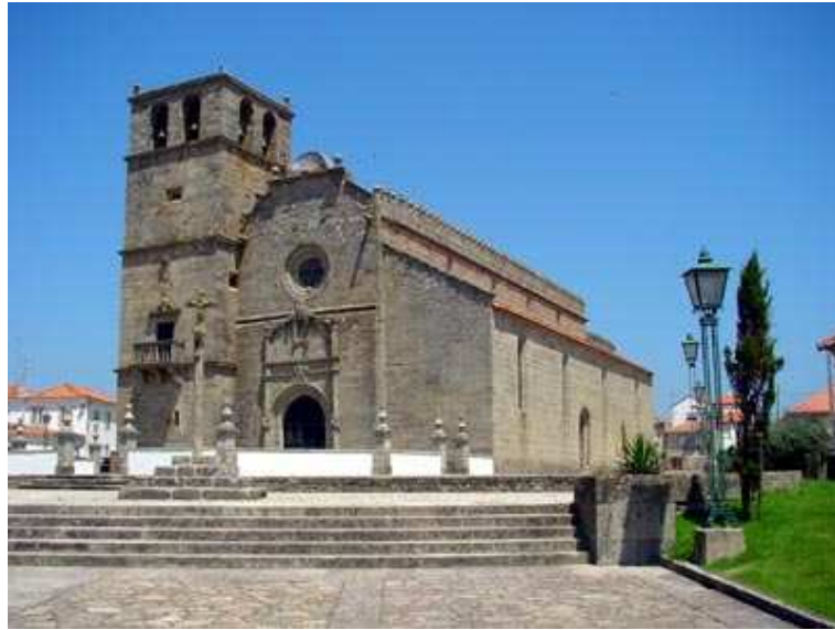
Fig. 23.2 – Fachada principal da igreja de Santa Maria de Azurara [46]
