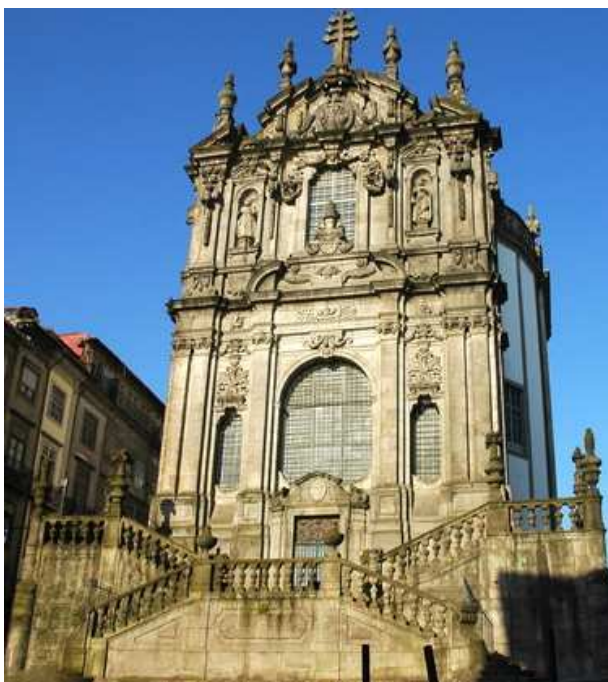
Fig. 8.1 – Fachada principal da igreja dos Clérigos (Porto) [18]
