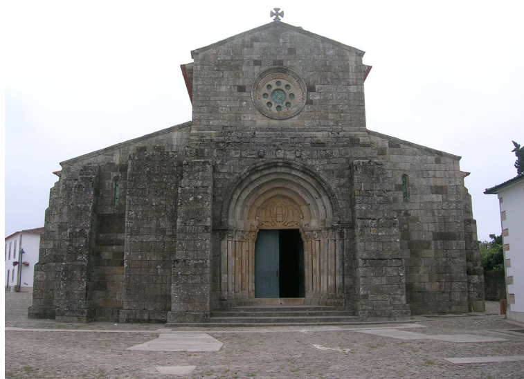
Fig. 41.1 – Fachada principal da igreja de São Pedro de Rates [72]
