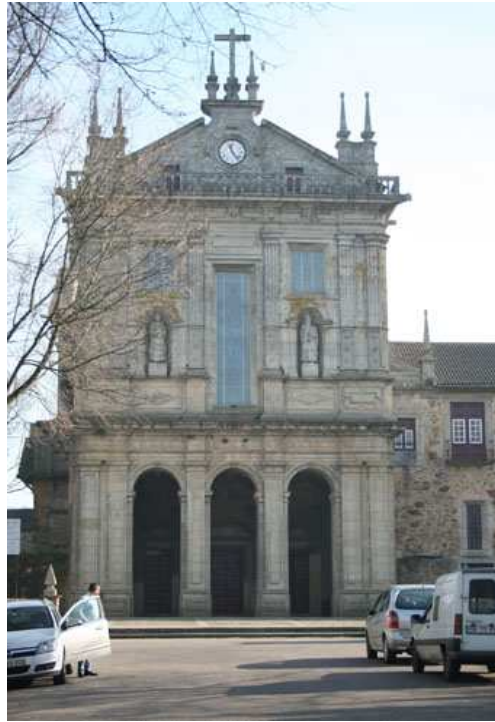
Fig. 10.2 – Fachada principal da igreja do mosteiro de Grijó [21]
