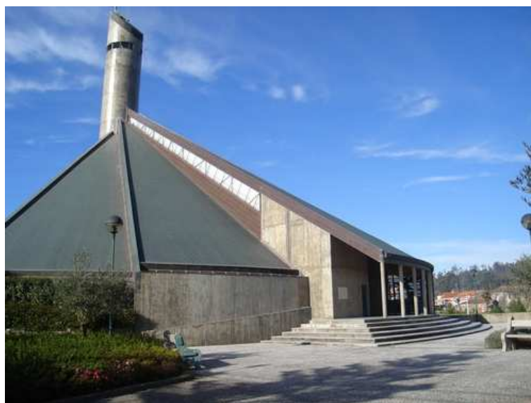
Fig. 48.1 – Vista lateral da igreja de Seroa (Paços de Ferreira) [84]
