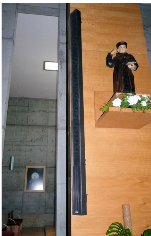
Figura 5.12 – Sistema de reforço electroacústico na igreja nova [foto da autora]
