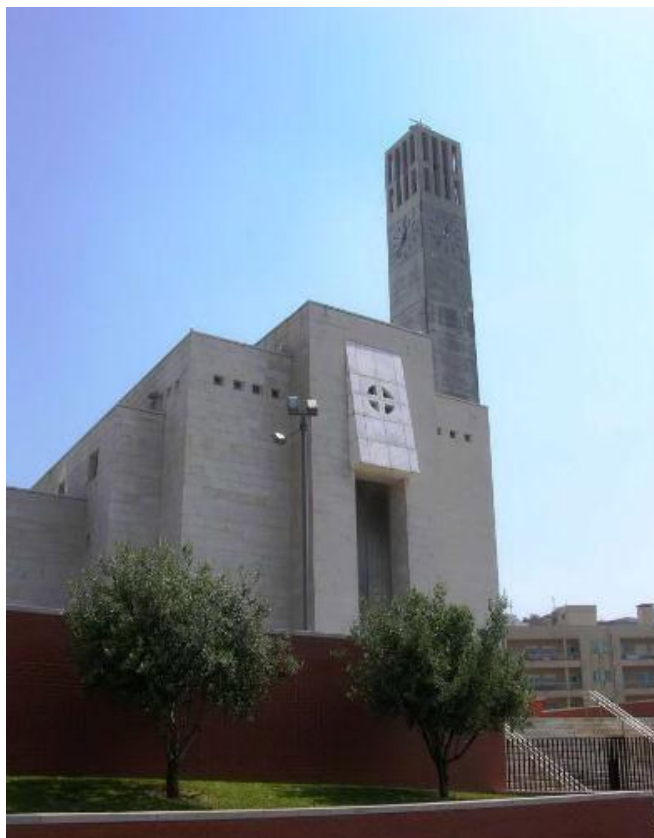
Figura 4.7 – Fachada da Igreja Nova de Santo Ovídio [10]
