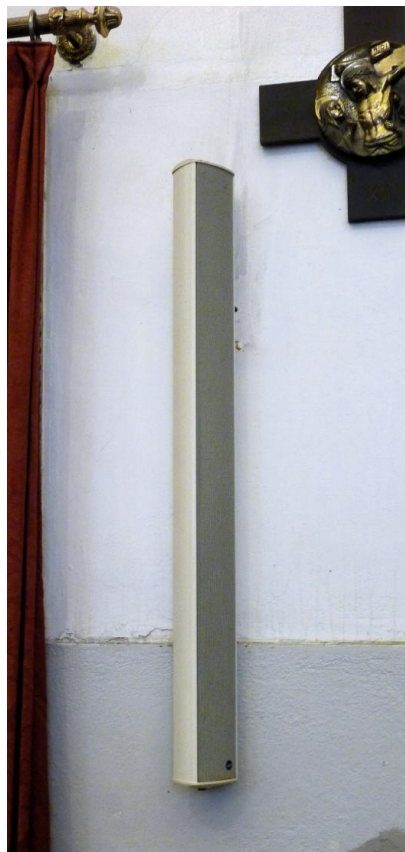
Figura 5.11 – Sistema de reforço electroacústico na igreja antiga [foto da autora]
