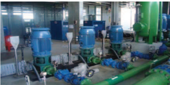
Figura 23. Estação elevatória de adução à rede Y.
