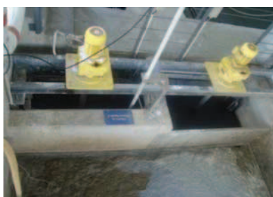
Figura 7. Tanque de mistura rápida.
