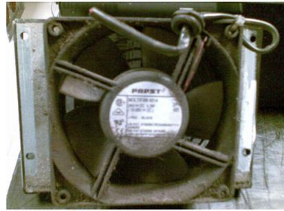
Fig. 8. Sujidade, corrosão e mau funcionamento de unidades de ventilação.
