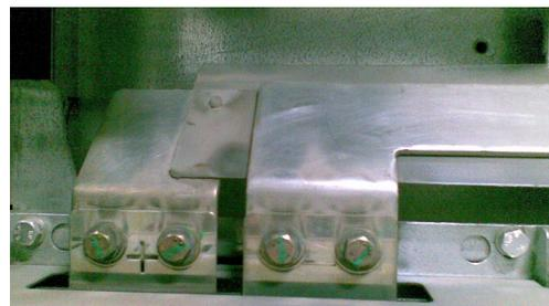
Fig. 10. Barramento DC com sujidade intensa e indícios de pontos quentes e de picagem.
